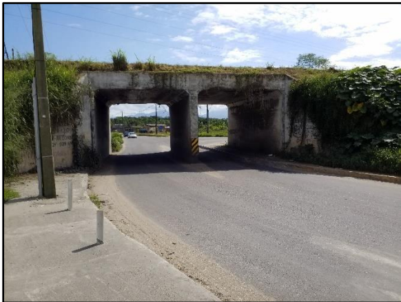
Figura 42 - Situação da trincheira com a ciclovia
